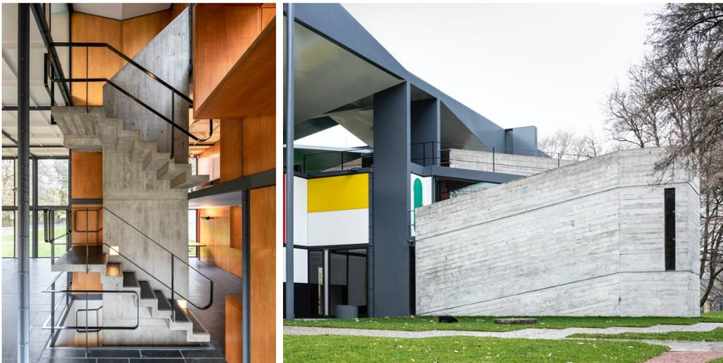
Abb.8/9: Treppe und Rampe aus Sichtbeton (Pavillon Le Corbusier, 2025)
